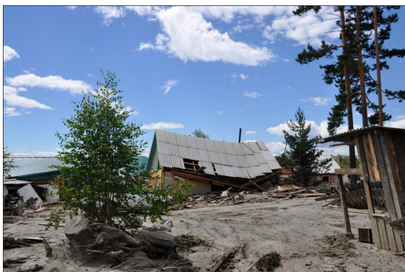
Фото 3-1. Фото 3-2. Фото 3-3. Грязекаменный поток похоронил часть домов на окраине поселка, а другую разрушил и, встретив лесной массив, потерял скорость и остановился.
