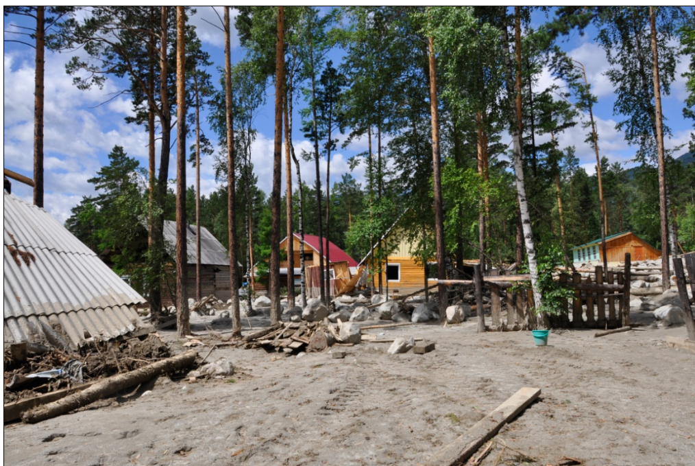
Фото 5. Лес, отфильтровав грязекаменную массу, спас дома от разрушения.
