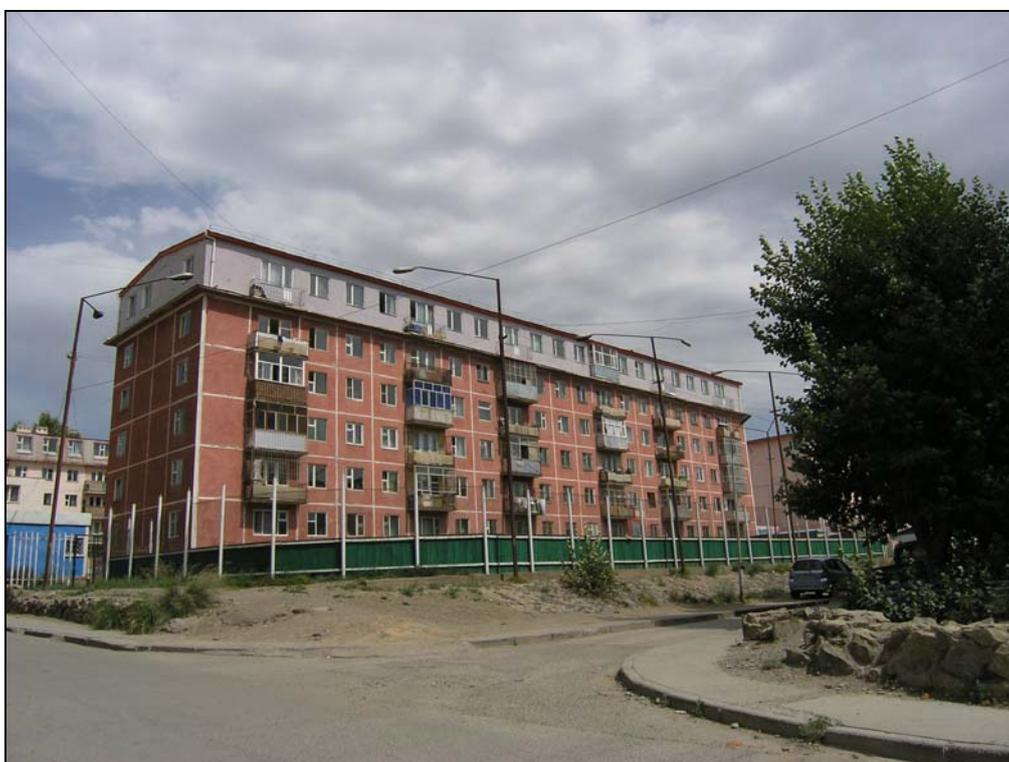
**Рис. 8.** Надстройка панельного жилого здания, возведенного при содействии бывшего СССР, г. Улаанбаатар.
